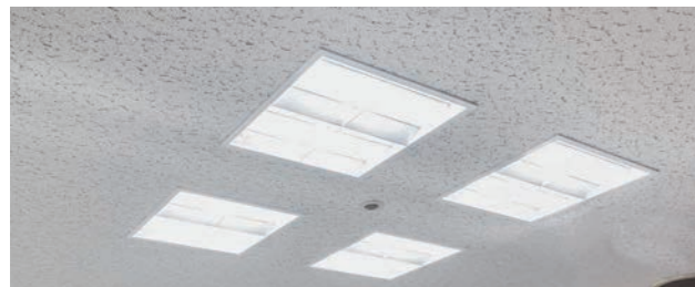
オフィス専有部LED照明化工事進捗率
